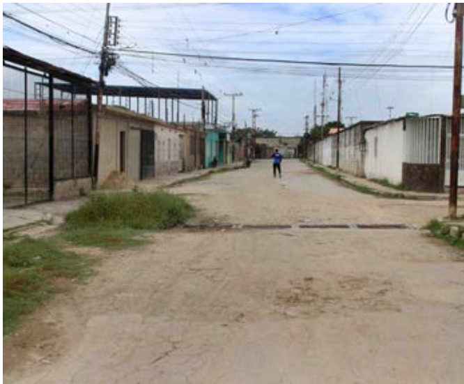
La calle se encuentra llena de escombros y maleza
