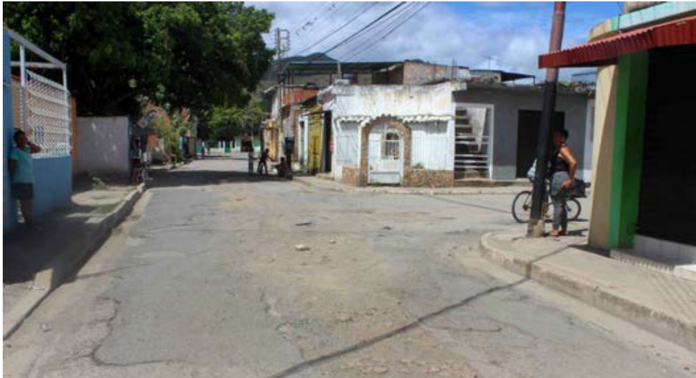
Quedan inconclusas las labores de sustitución de colectores
