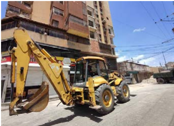
Se utilizó maquinaria pesada
