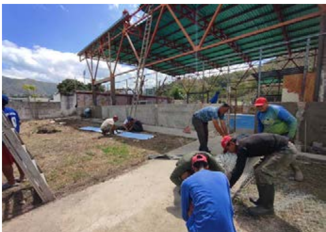
Los trabajos se están realizando desde hace por lo menos una semana
