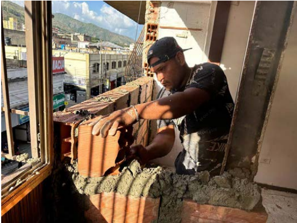
Las labores se están realizando a cabalidad
