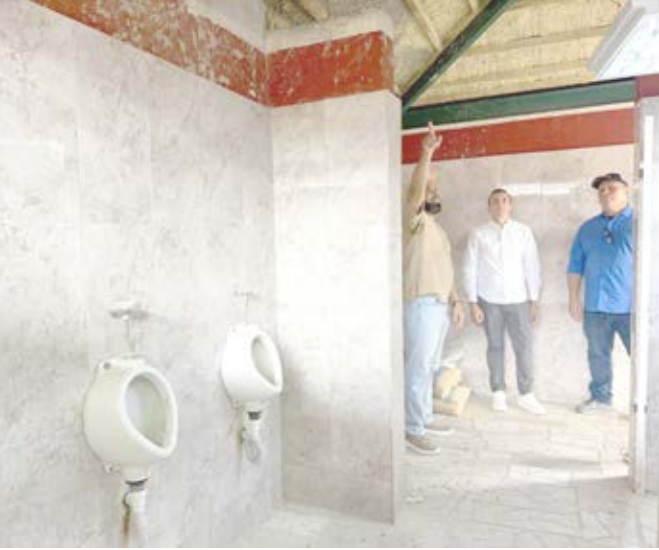
“Ya avanzamos con paso firme en la electrificación de las gradas y la rehabilitación de los baños”, dijo el funcionario gubernamental
