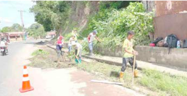
Las cuadrillas están desplegadas
