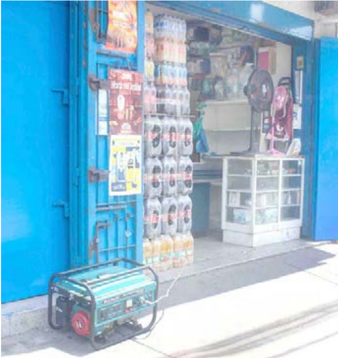
Este martes por todos lados se escuchaba el ruido de las plantas eléctricas
