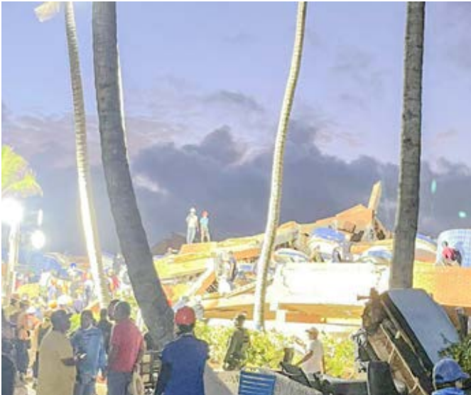
En ruinas quedó el edificio 2 de “Lamar Suites” en Tucacas
