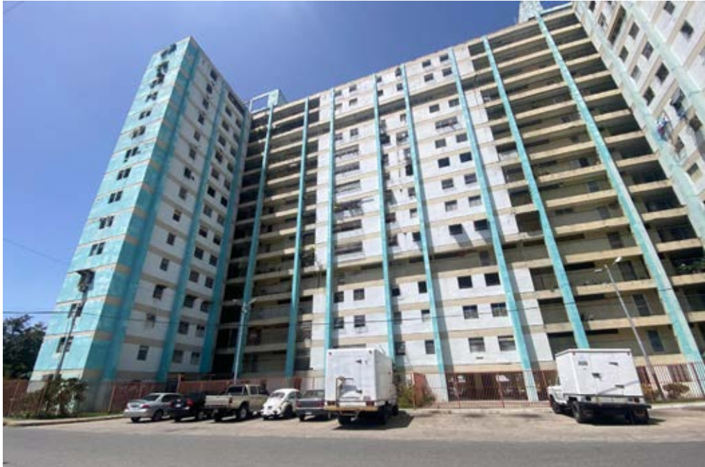
Habitantes del bloque 45 se mantienen en evacuación preventiva
