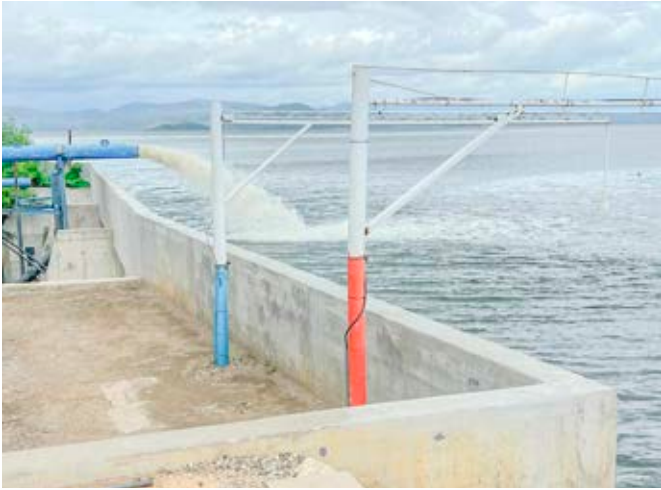
El muro del lago sin novedad en el sur de Maracay
