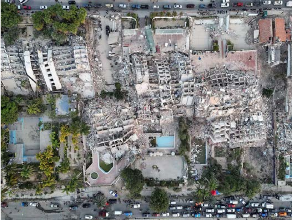
Imagen aérea tomada con un dron donde muestra los edificios destruidos por los terremotos en La Guaira, el pasado 24 de junio
