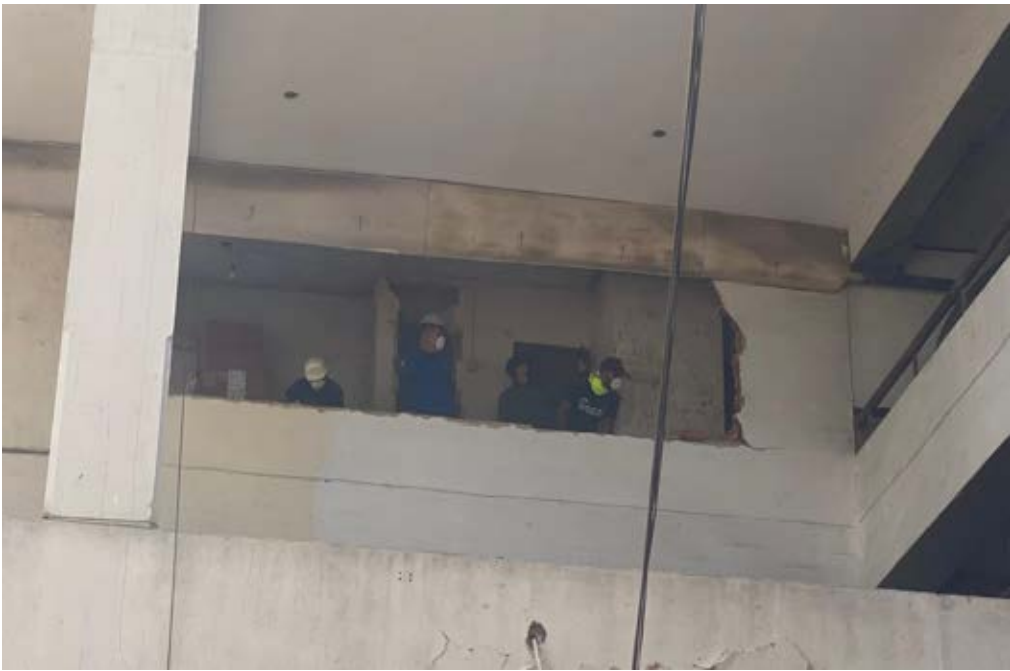
Cuadrillas se desplegaron en el conjunto residencial
