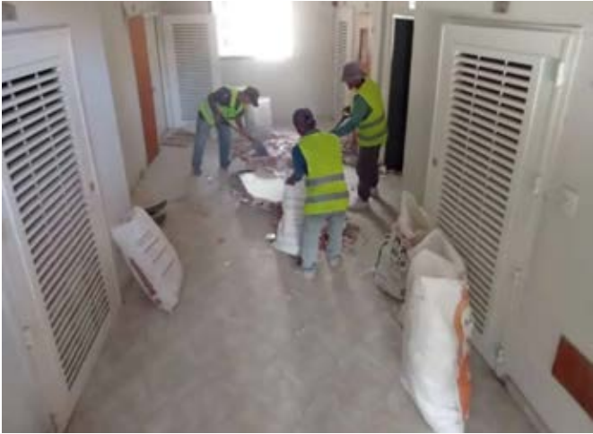
Las cuadrillas limpiando los edificios afectados
