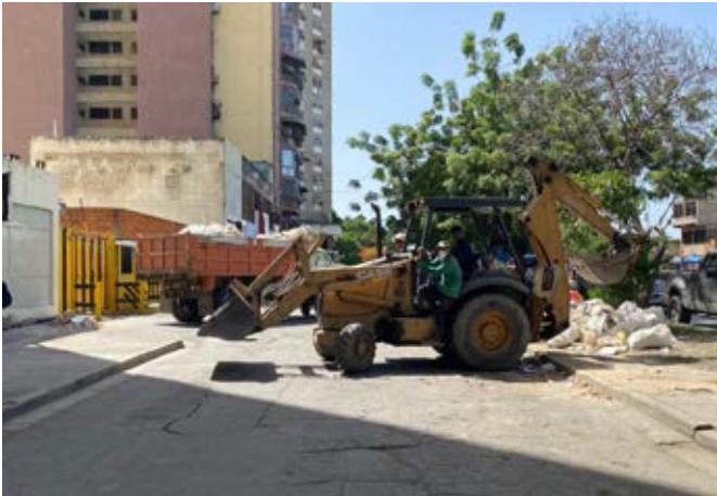
Realizaron la remoción de escombros y despeje del área
