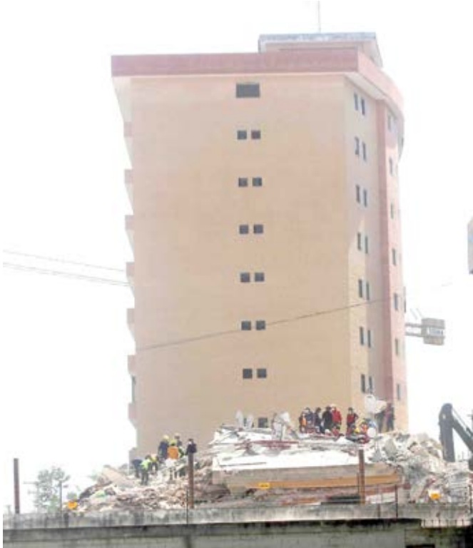
Personal trabajando en la remoción de escombros
