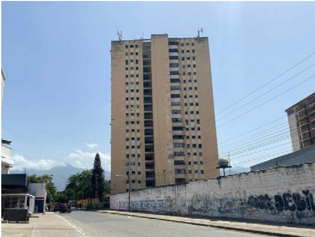
Se espera pronunciamiento sobre el estado actual de la edificación
