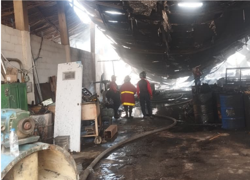
Los depósitos de la colchonera quedaron reducidos a cenizas
