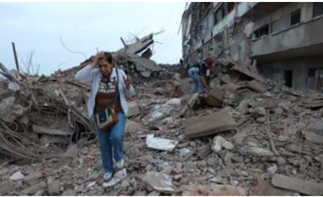
Habitantes de La Guaira, reclamaban la presencia de funcionarios de PC y demás organismos para ayudar a rescatar a las personas atrapadas bajo los escombros
