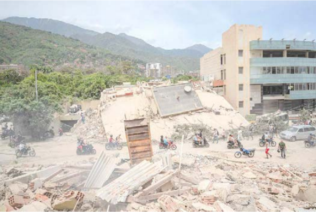
Un edificio quedó totalmente destruido
