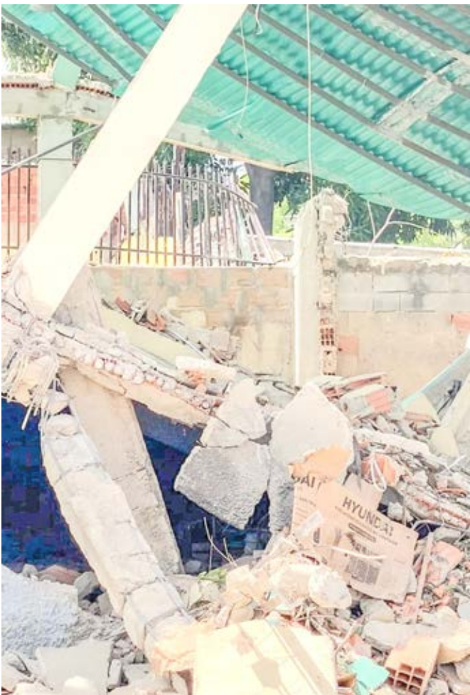
Demolida la casa colapsada en Los Cocos
