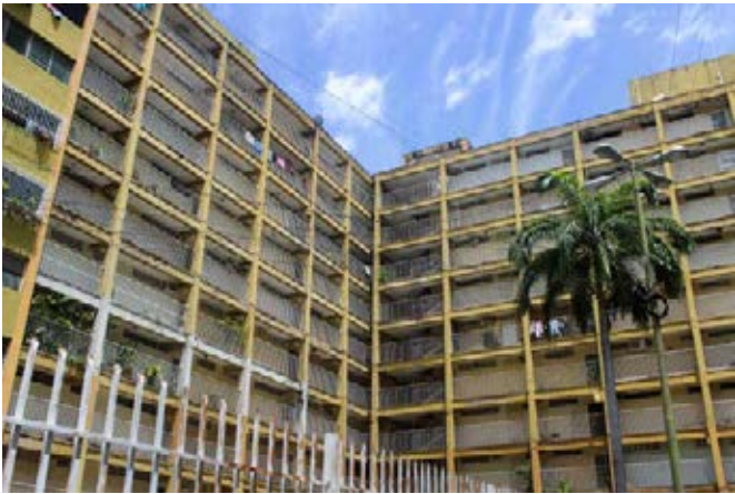
Los edificios no sufrieron daños de gravedad
