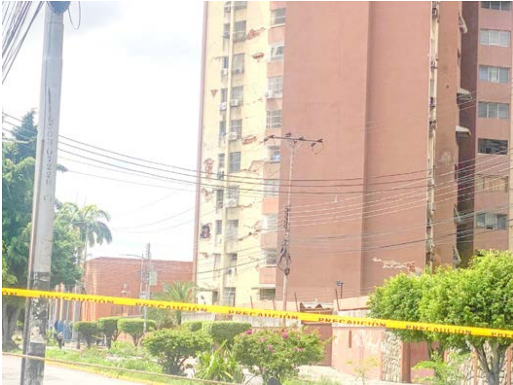
El edificio El Trébol sufrió daños considerables
