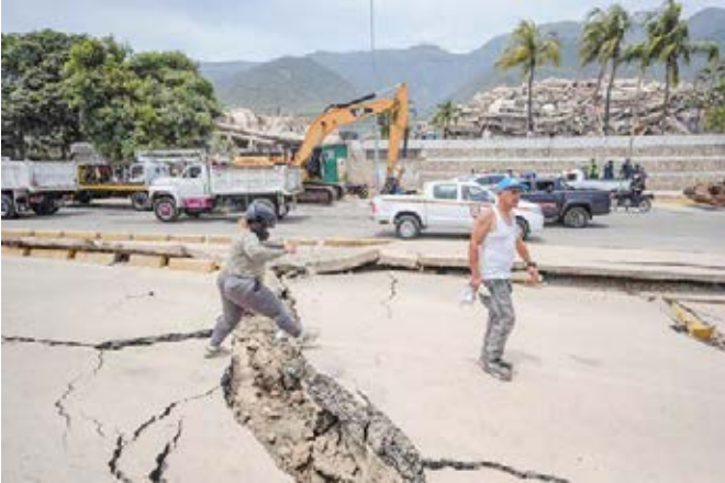
Calles y aceras quedaron destruidas
