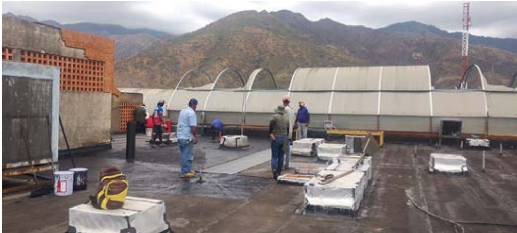
Llevaron a cabo trabajos de impermeabilización
