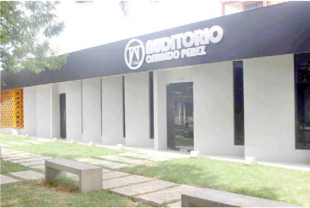
El auditorio y toda la estructura no presentaron daños
