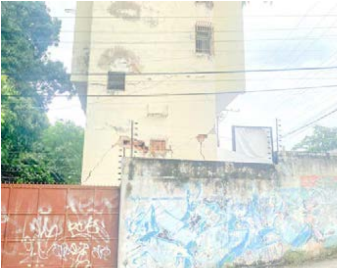
Al edificio Torrice lo repararán la próxima semana
