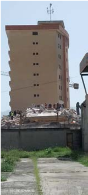
Los trabajos de remoción se mantienen en la zona afectada
