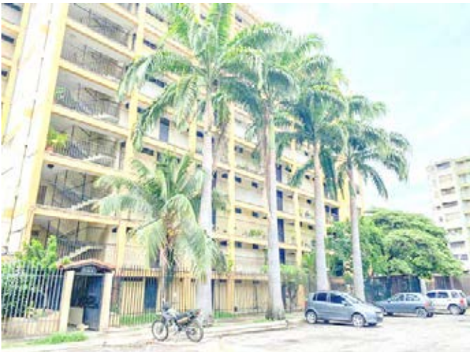
La estructuras en los “Súper Bloques” están intactas
