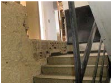
La Torre Cuatricentenaria de Cagua también comenzó a ser reparada
