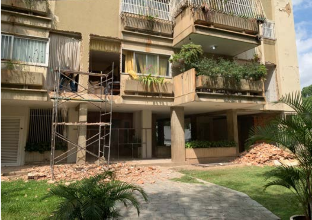
Se ejecutan trabajos en varios de los apartamentos del edificio
