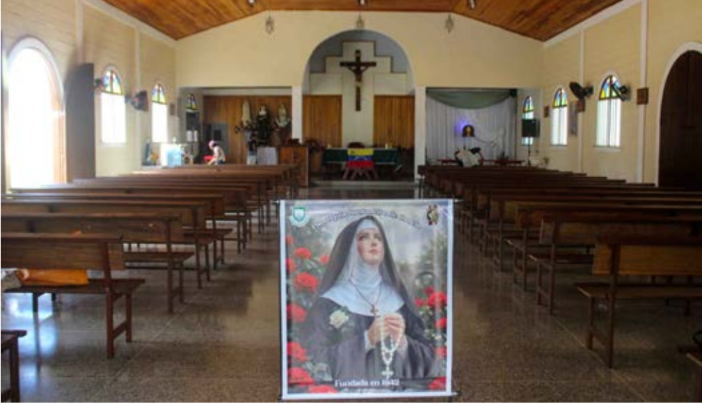
Iglesia Santa Rita de Casias sin daños
