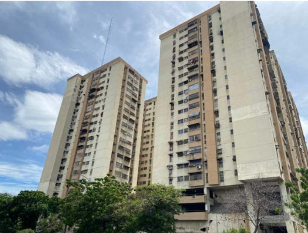
Los trabajos dentro de las edificaciones continúan
