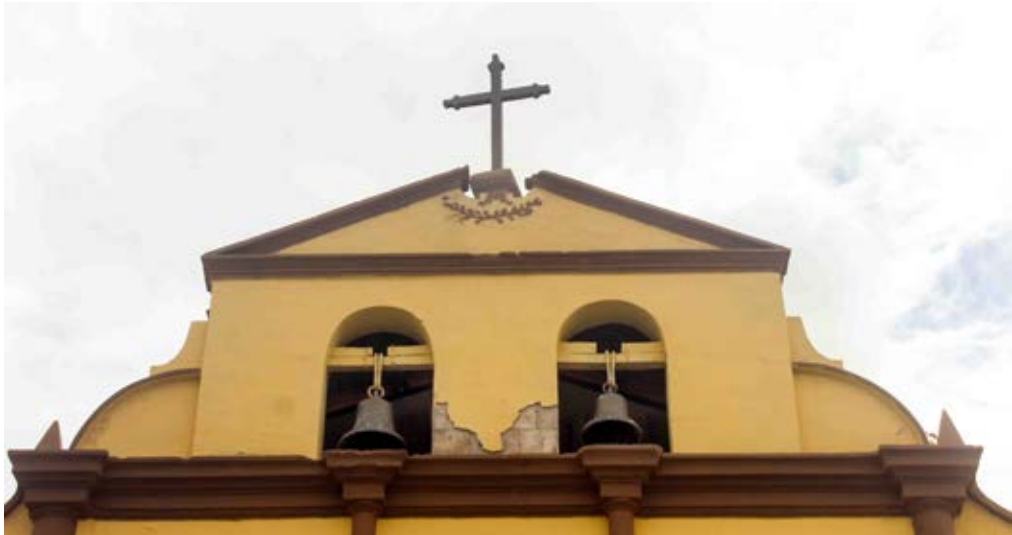
La iglesia sufrió daños leves en la fachada
