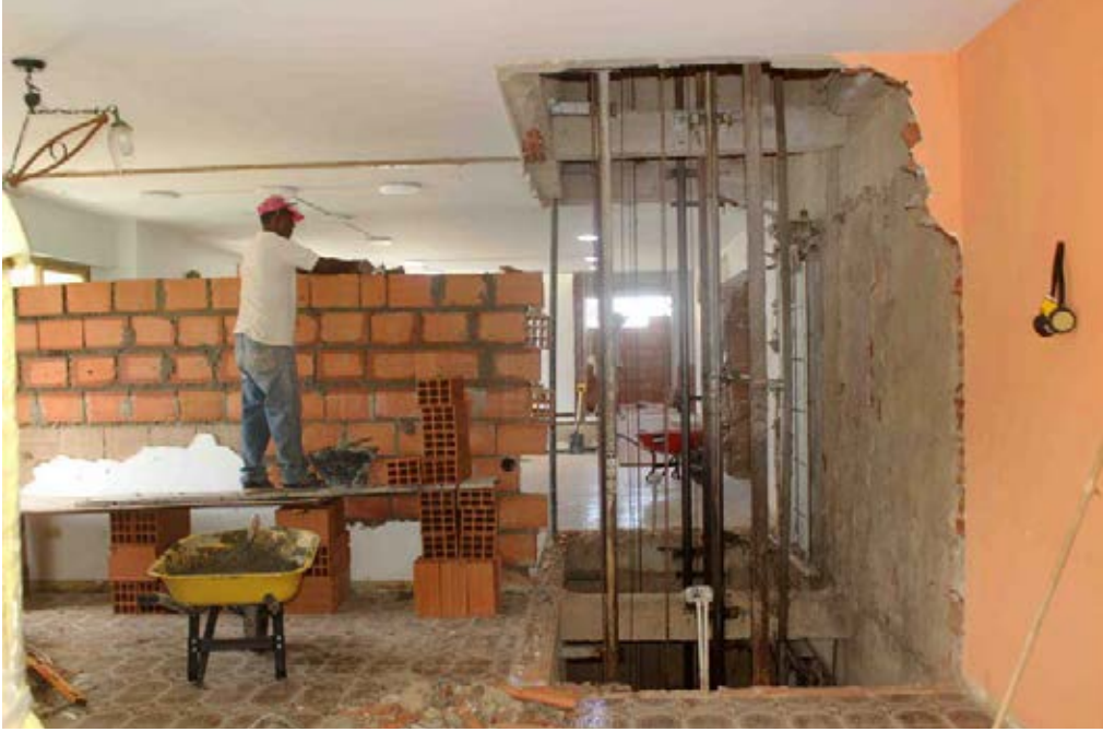
En el complejo se levantan gran cantidad de paredes
