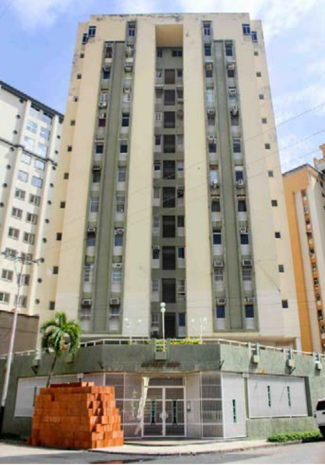
Hay edificaciones que comenzaron a reparar con autorización
