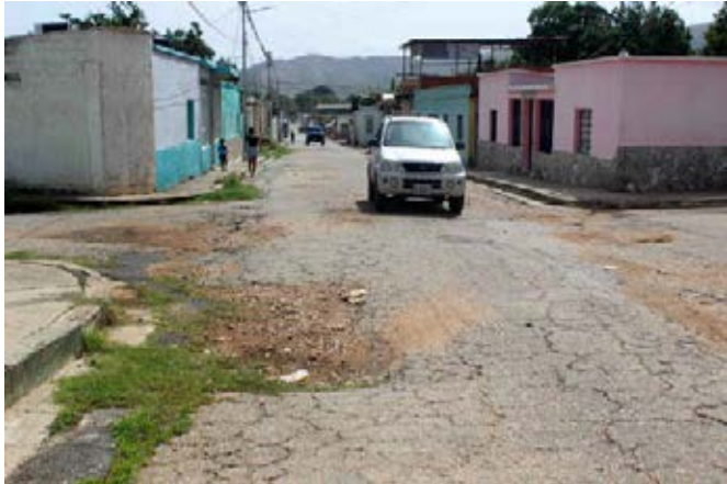
Estado de las calles y problemas de servicio eléctrico se suma a las carencias
