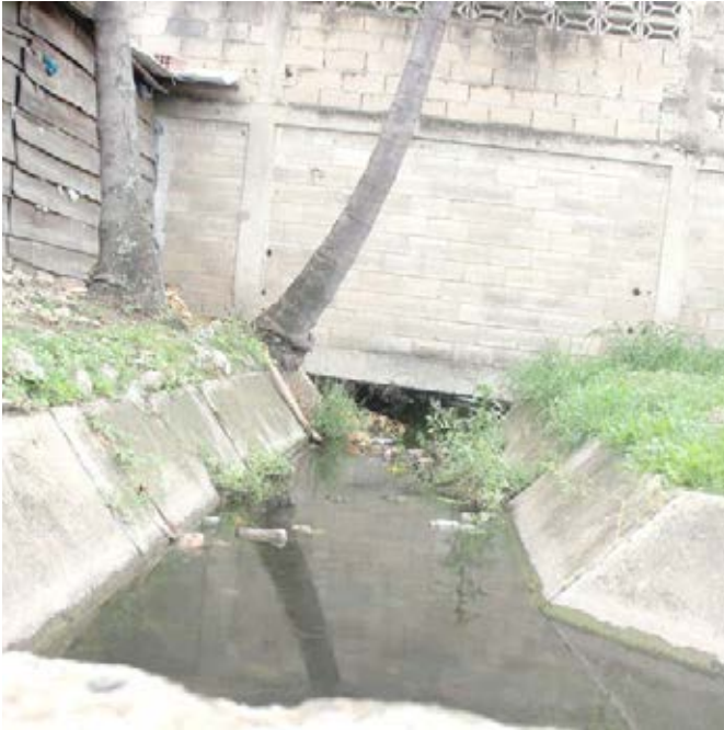
Canal de la zona
