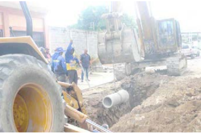
Sustitución con el apoyo de excavadoras
