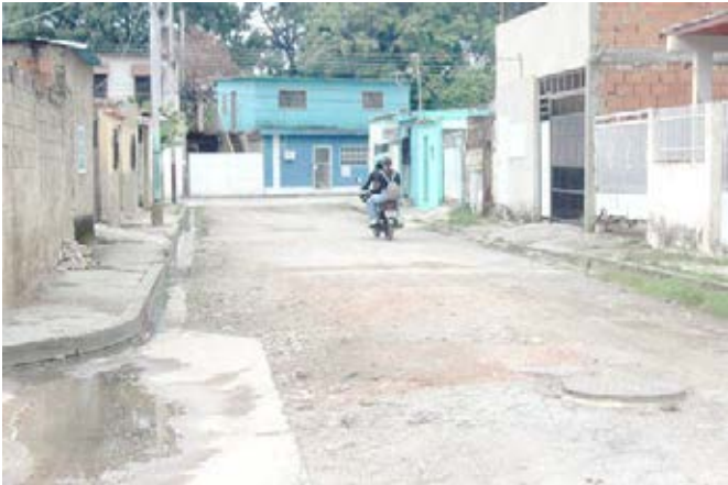
Calle Cumboto en mal estado
