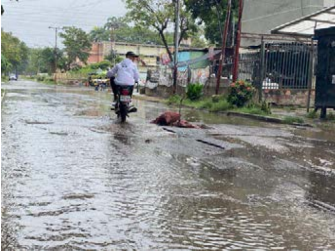
Vecinos alertan sobre el peligro de los huecos
