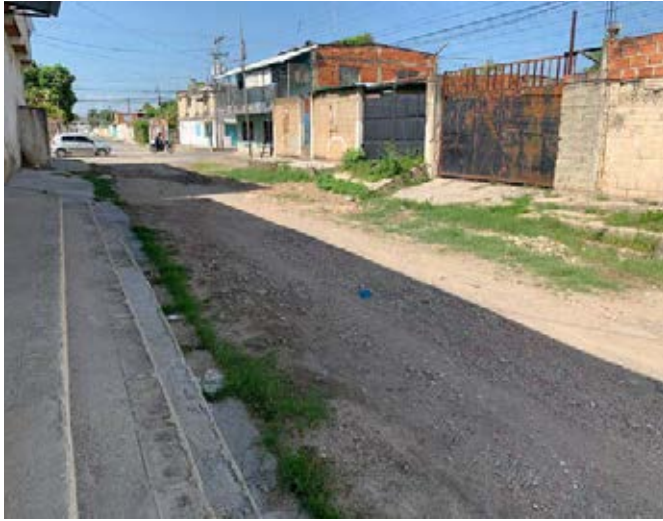
El agua se filtra a las casas
