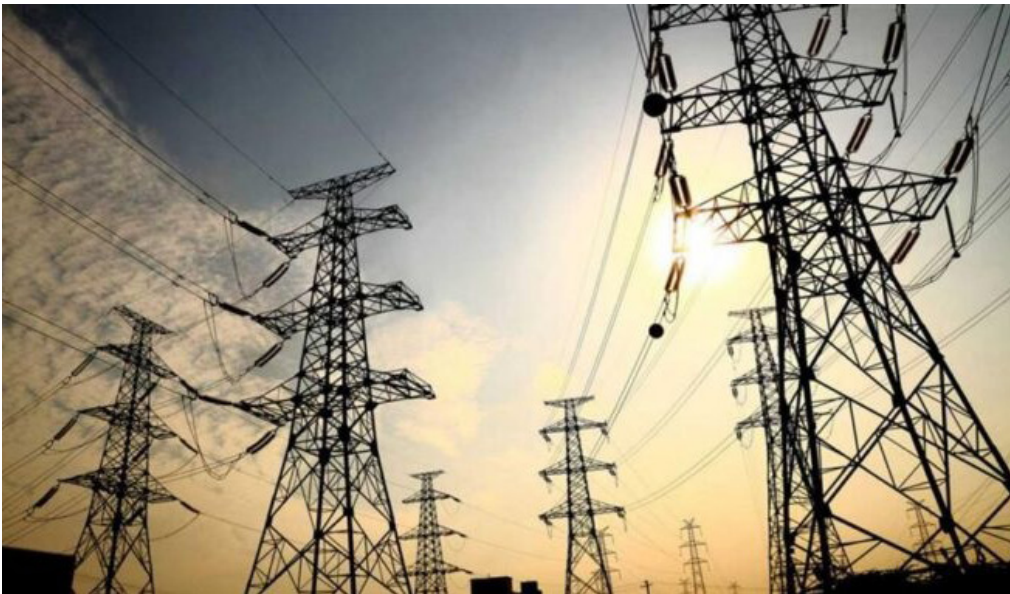
Nuevo apagón eléctrico nacional afectó, ayer, a Cuba
