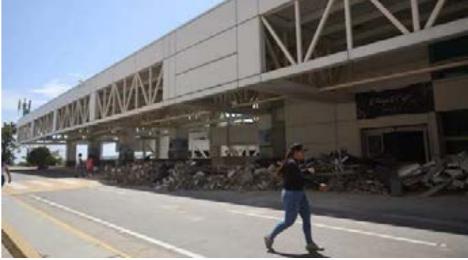
Mientras el aeropuerto de Maiquetía afectado por los terremotos se recupera de los daños sufridos varias terminales aéreas operan como aeropuertos alternativos
