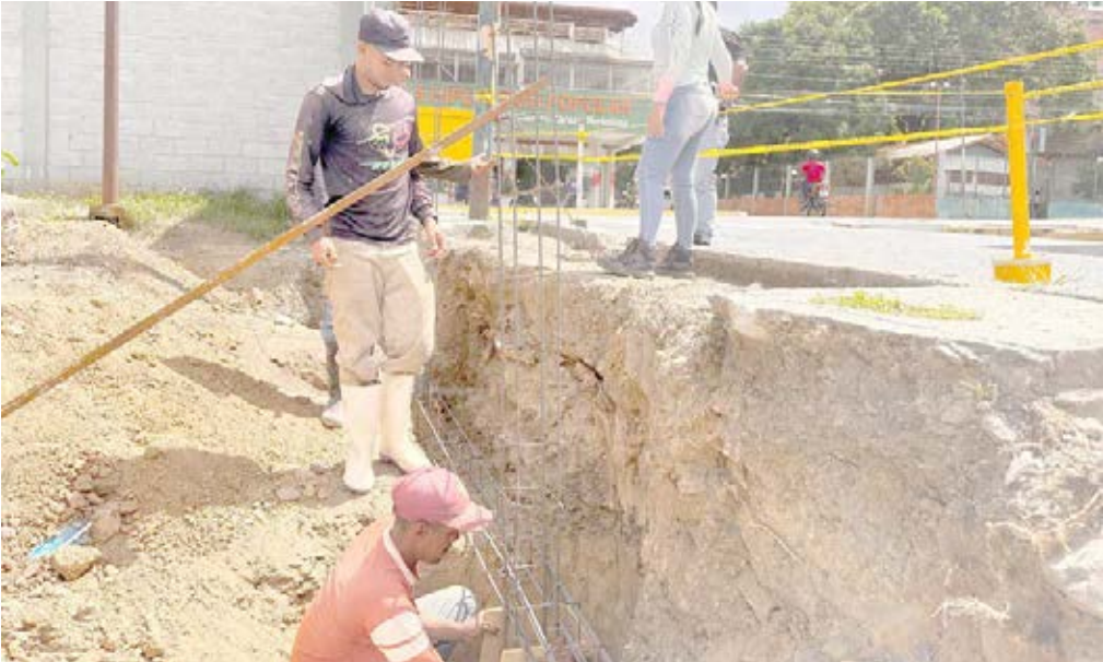
Los trabajos van avanzando
