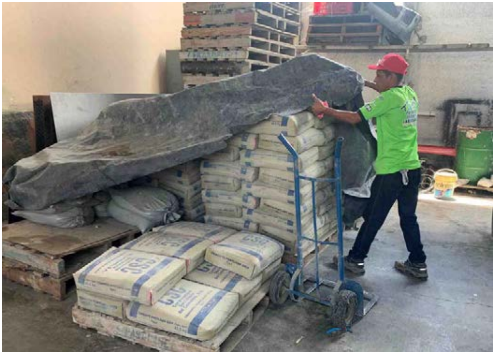
Cemento y arena son de alta demanda
