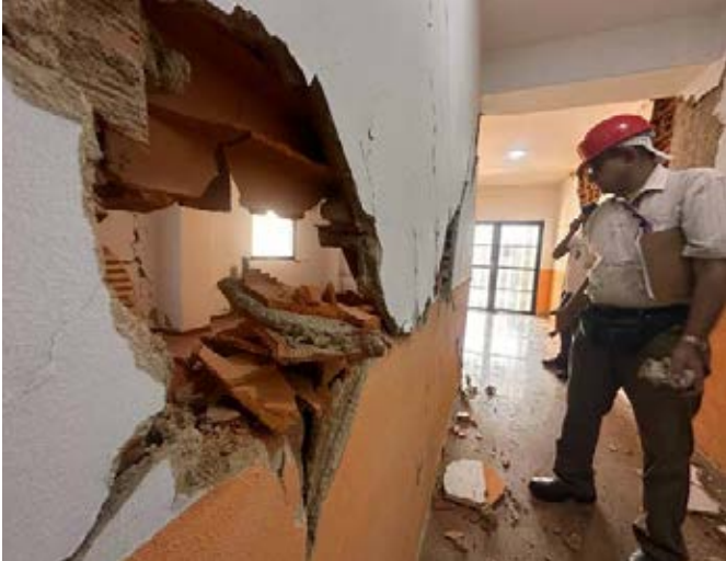
Las autoridades durante la inspección de la edificación
