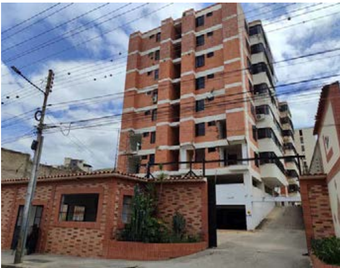
El edificio Renacer sigue en pie aunque un poco fracturado
