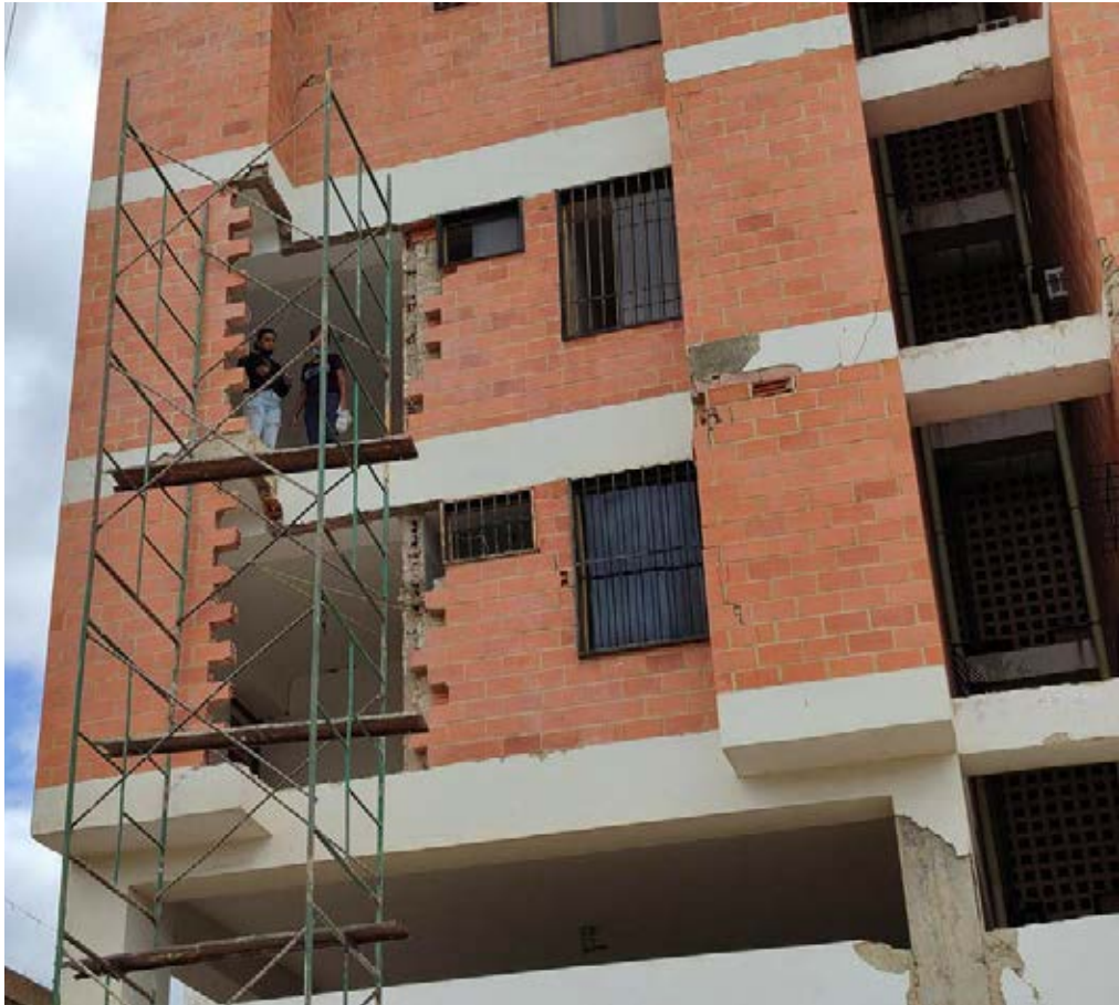
Ya se están haciendo labores en el edificio
