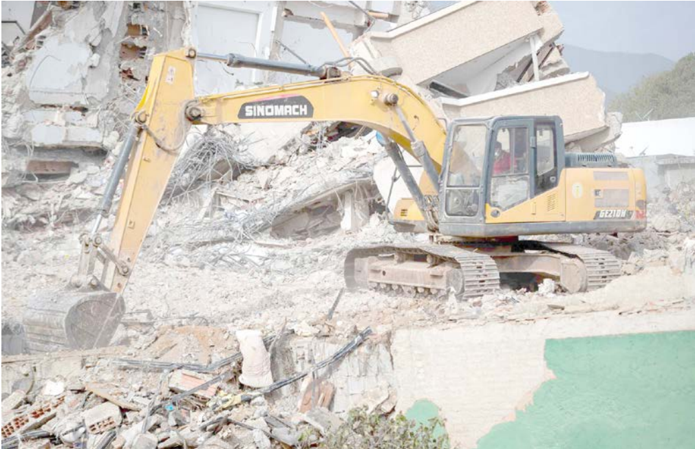
Con maquinaria pesada remueven los escombros
