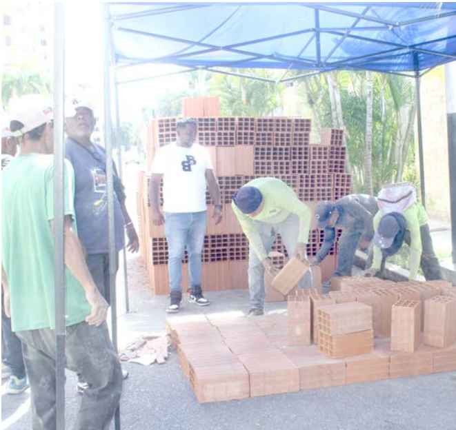
En varios edificios de Andrés Bello, están llegando materiales de construcción
