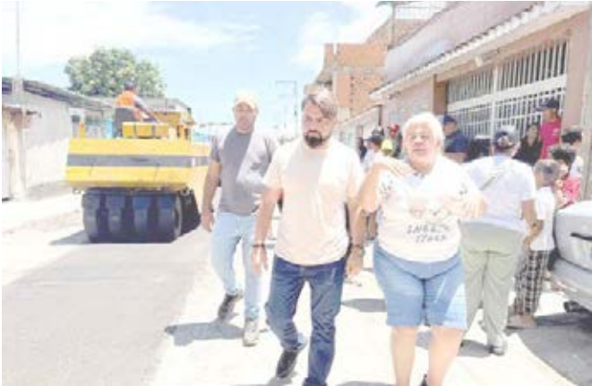
El alcalde Rafael Morales supervisó los trabajos de asfaltado
