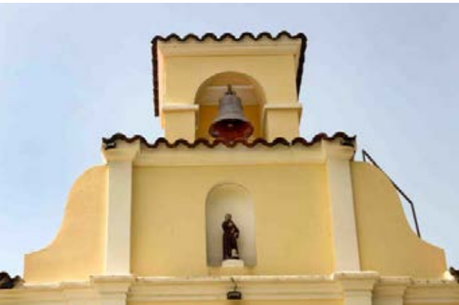
Dentro y fuera de la edificación no existen señales de afectaciones
