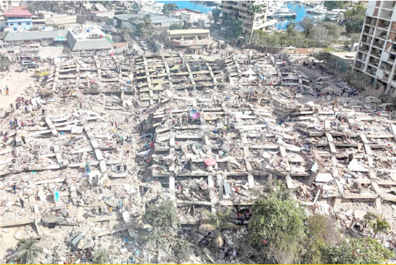
Edificios destruidos en Caraballeda, estado de La Guaira, tras los terremotos del 24 de junio
