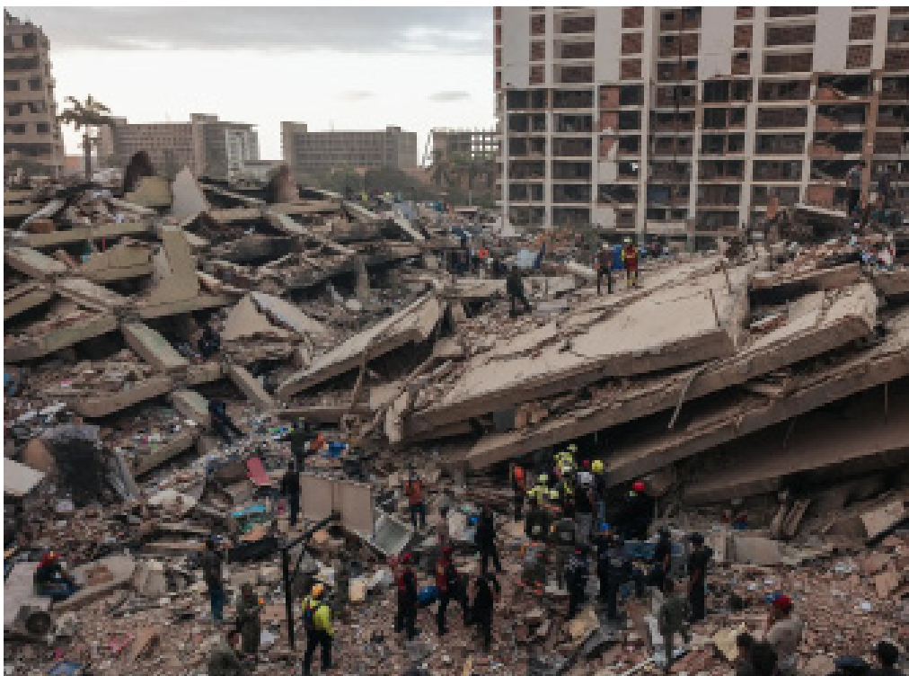
Lo que llevó tiempo para su construcción, se desplomó en cuestiones de segundos
